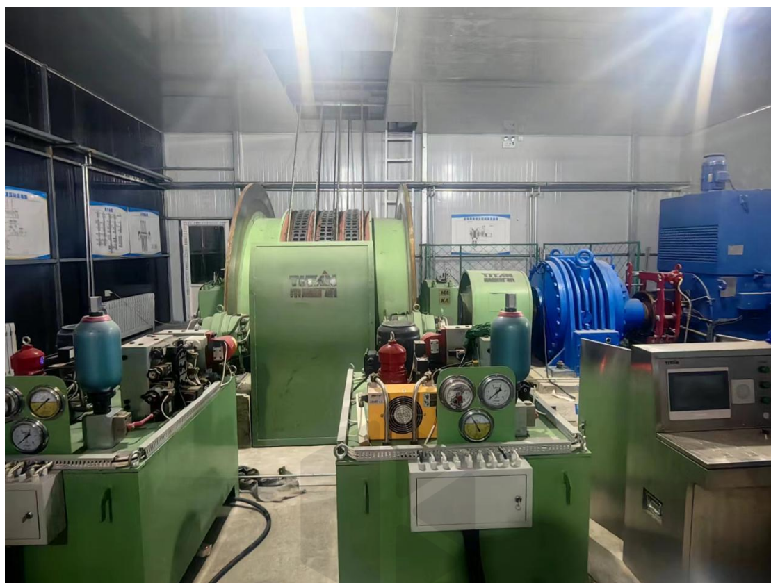
图 2.4-3 SJ3 提升机房
