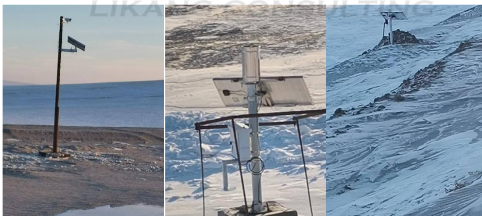
图 2.10-3 视频监控、浸润线位移、坝体位移
