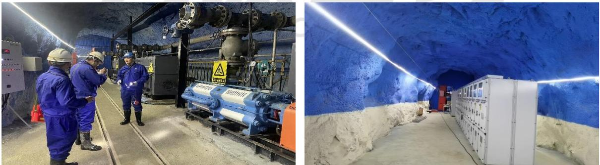
图 2.4-2 -827 中段水泵房及配电硐室
