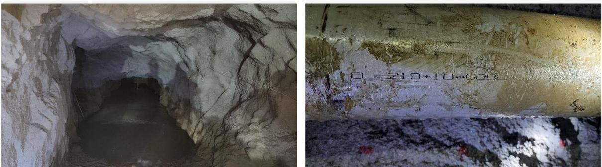
图 2.4-3 -287 中段水仓及排水管路
