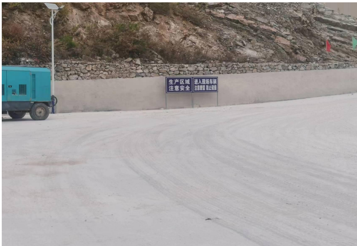
图 2.5-1 运输道路现场照片
