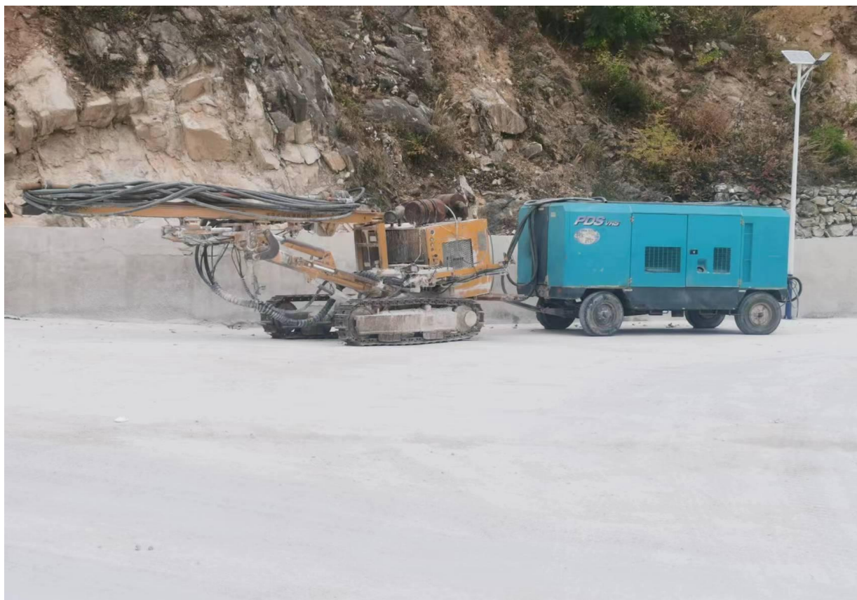
图 2.5-2 潜孔钻机现场照片
