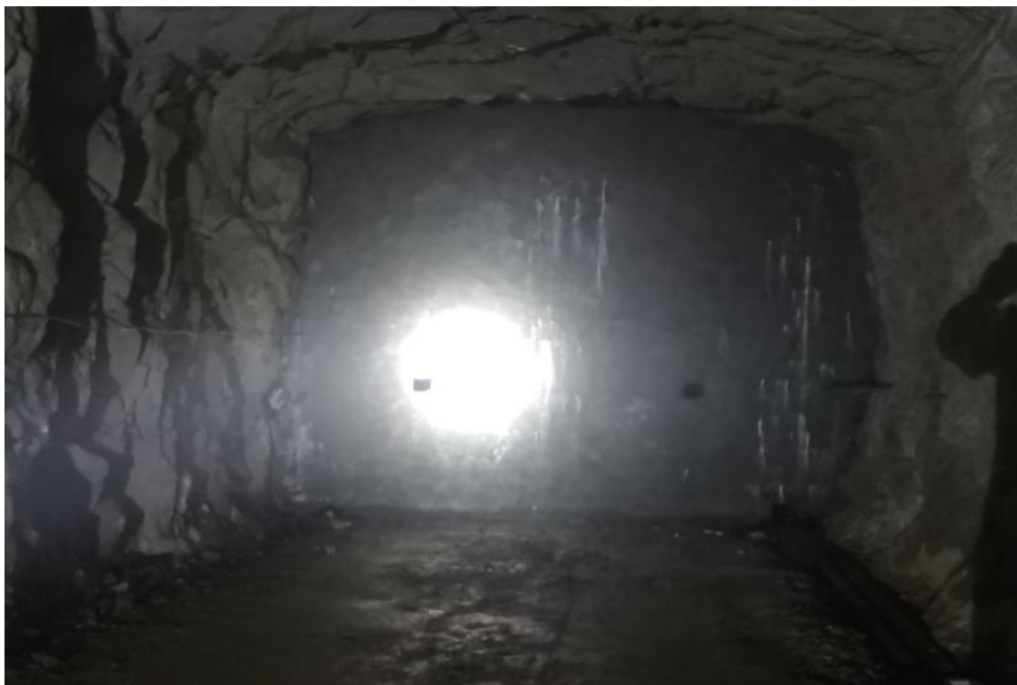
图 2.4-1 封堵墙现状照片
