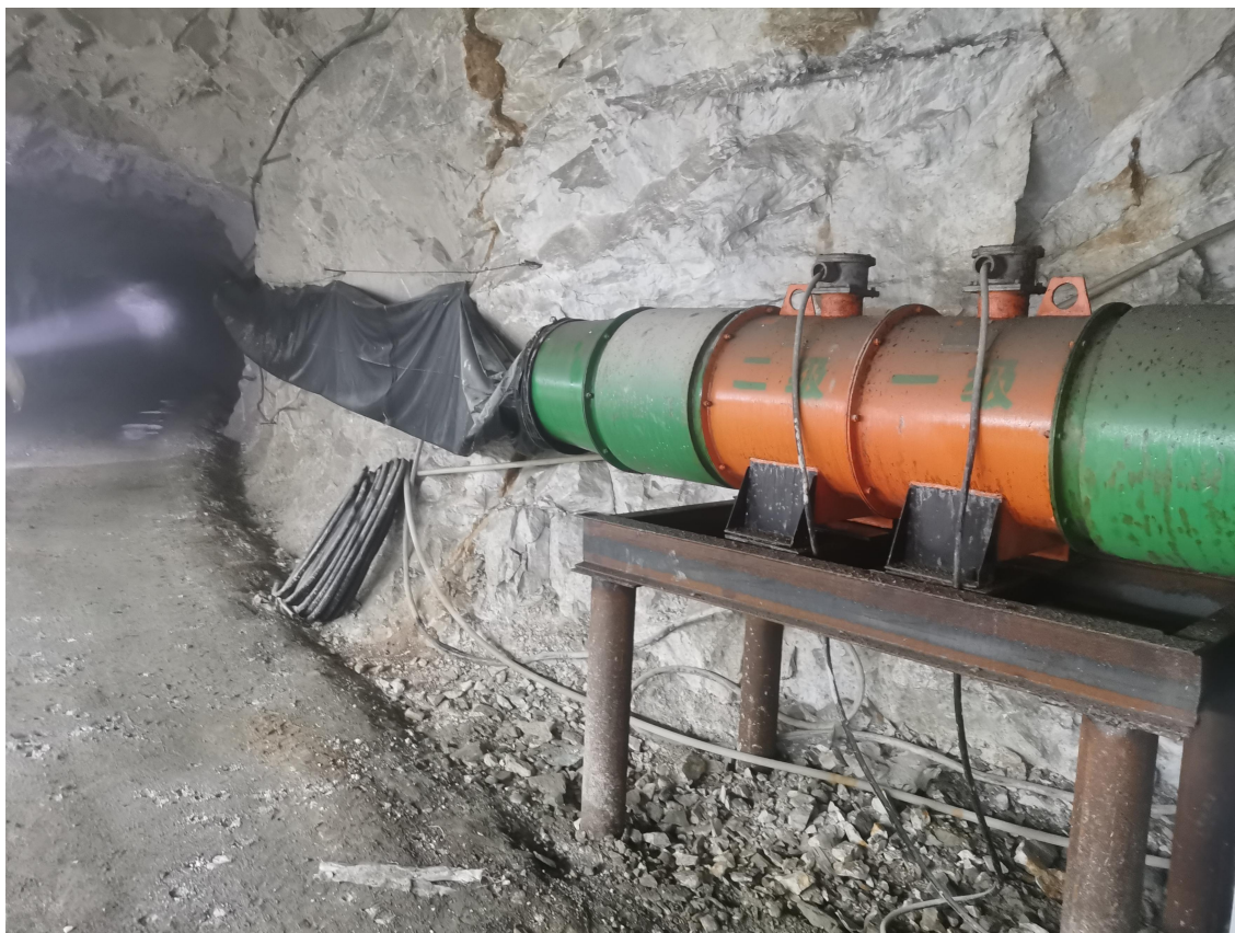
图 2.4-3 +467m 水平运输中段现状
